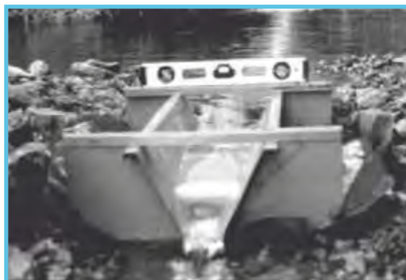
Figura 8. Aforador RBC verificando nivelación transversal
