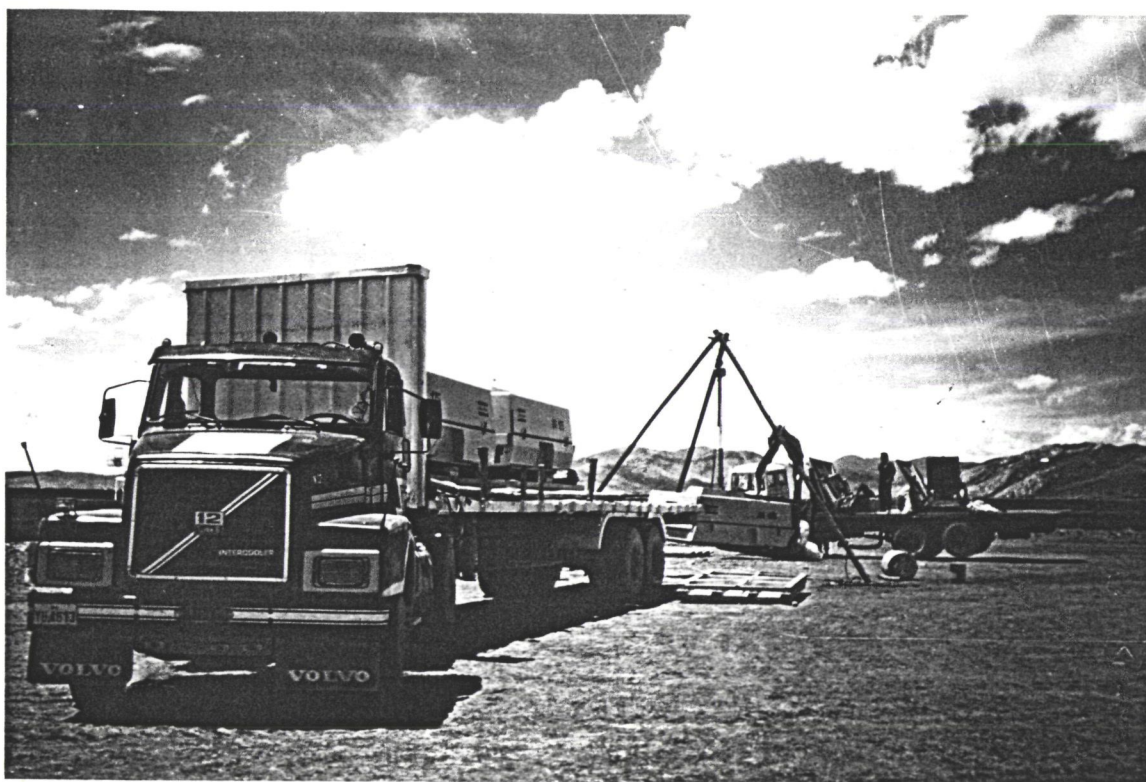
FOTO N° 01 Traslado de equipos de rehabilitación y bombeo
