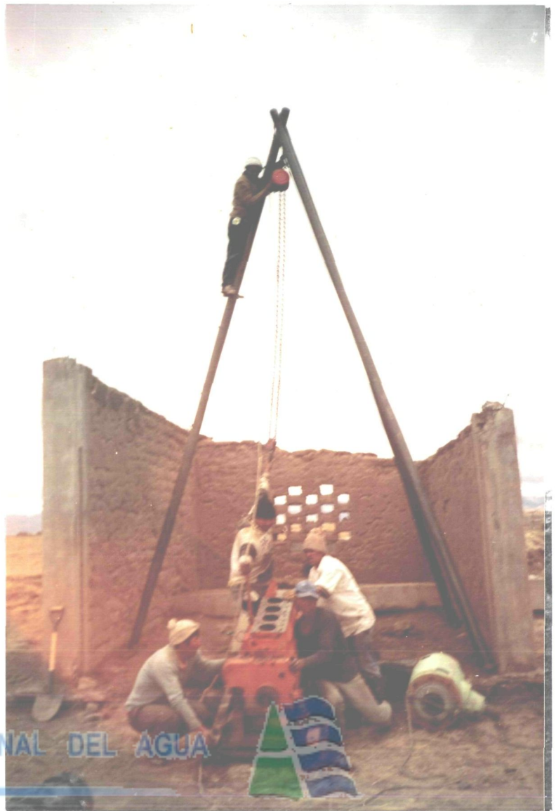
FOTO N° 01 Montaje del equipo de izaje para el inicio de la rehabilitación.
