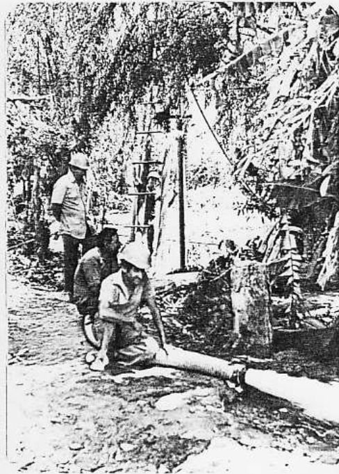
INYECCION DE AIRE COMPRIMIDO CON COMPRESOR PARA REALIZAR LA FASE DE DESARROLLO DEL POZO.
