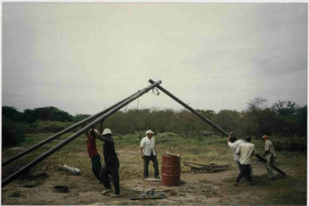
FOTO N° 01 Preparación del equipo de izaje para proceder al montaje de los equipos de rehabilitación.
