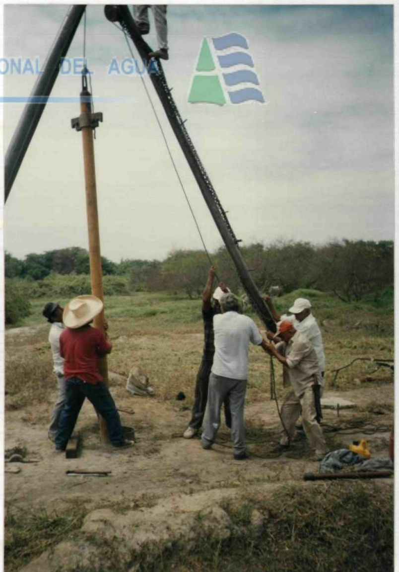
FOTO N° 01 Preparación del equipo de izaje para proceder al montaje de los equipos de rehabilitación.
