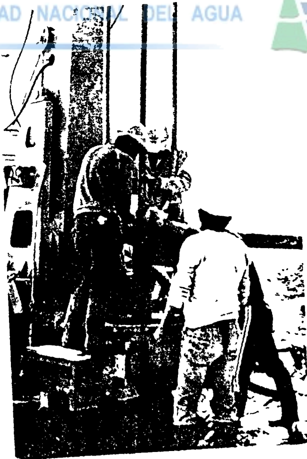
FOTO No. 18 MANTENIMIENTO DEL EQUIPO
