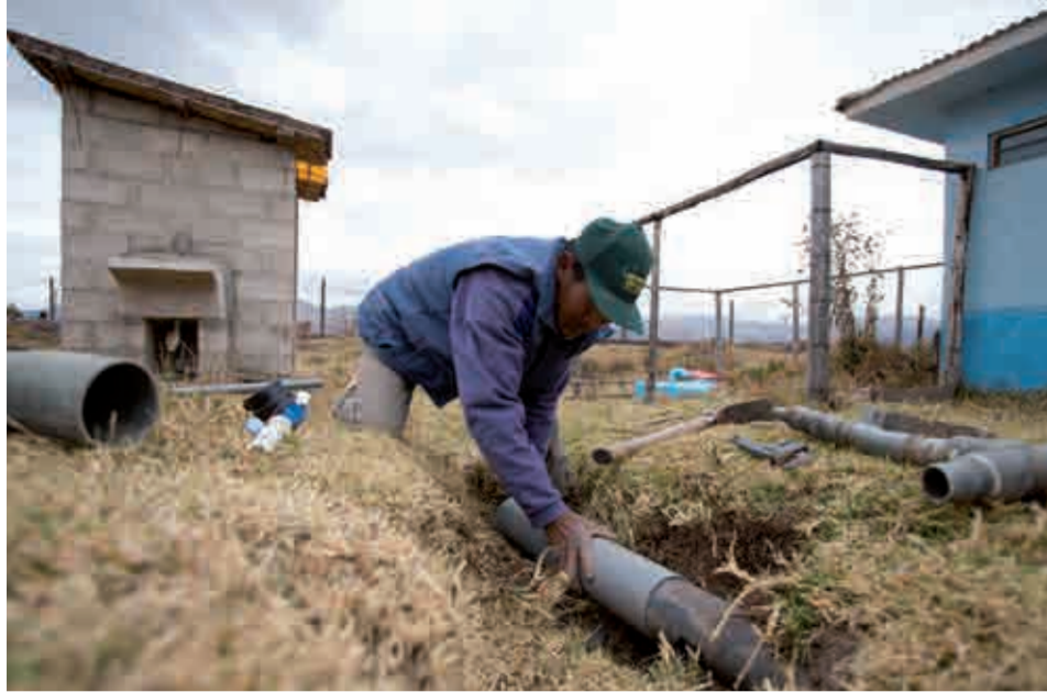
EN ACCIÓN. Emilio repara el sistema de reservorios en Markju.
