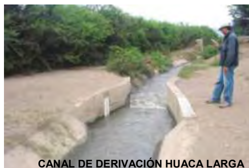
Cuadro N° 26 :Situación actual de las estructuras de control y medición.
