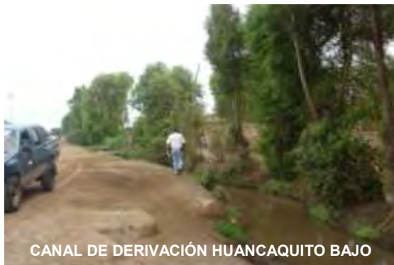
Cuadro N°40: Situación actual de la infraestructura de control y medición.
