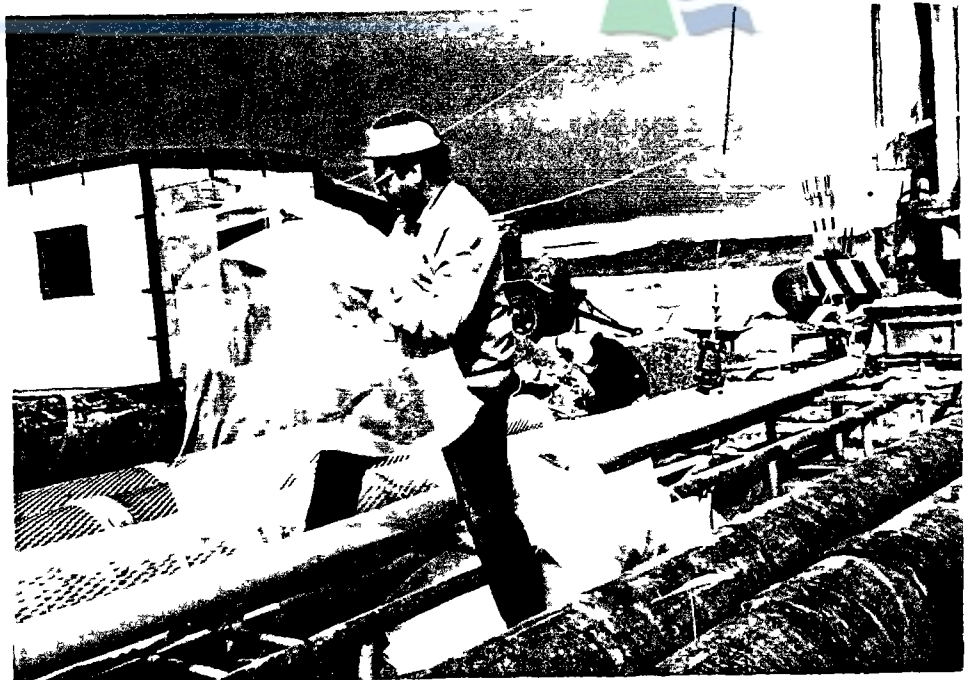
DETALLE DE MALLA DE NAYLON PARA ENVOLTURA
