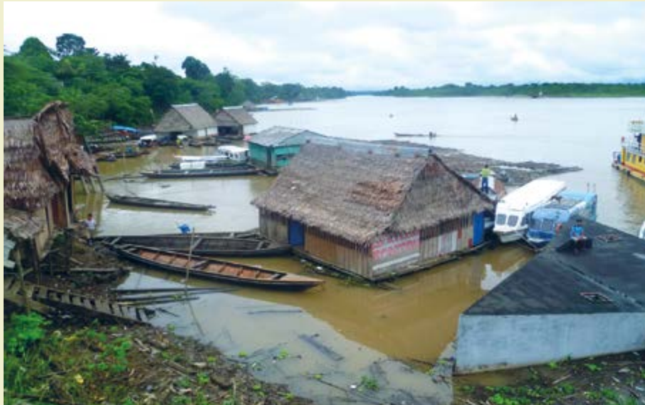
Viviendas flotantes en el río Napo, Mazan
