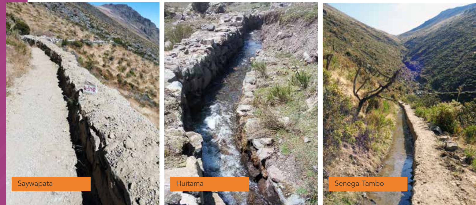
Figura 2 Imágenes de amunas rehabilitadas en la comunidad campesina San Pedro de Casta
