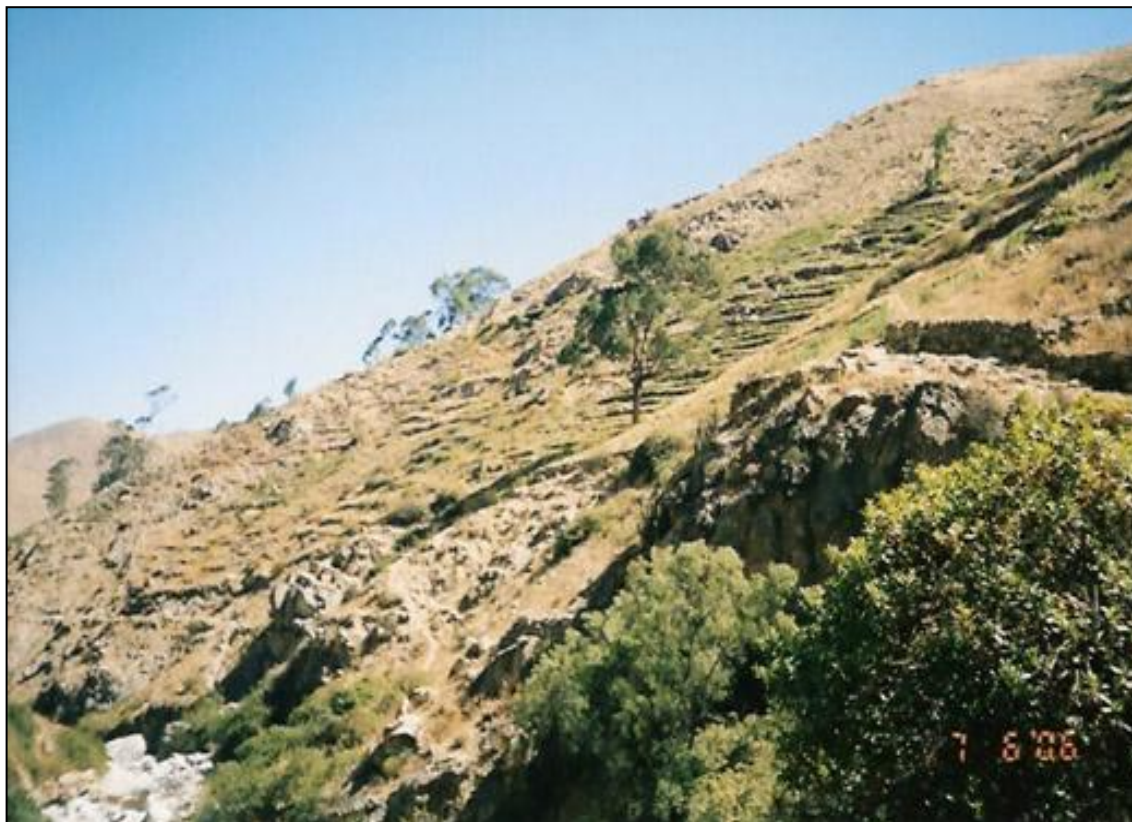
Foto N° 13 – Alternativa de Presa Yanac (Estribo derecho)
