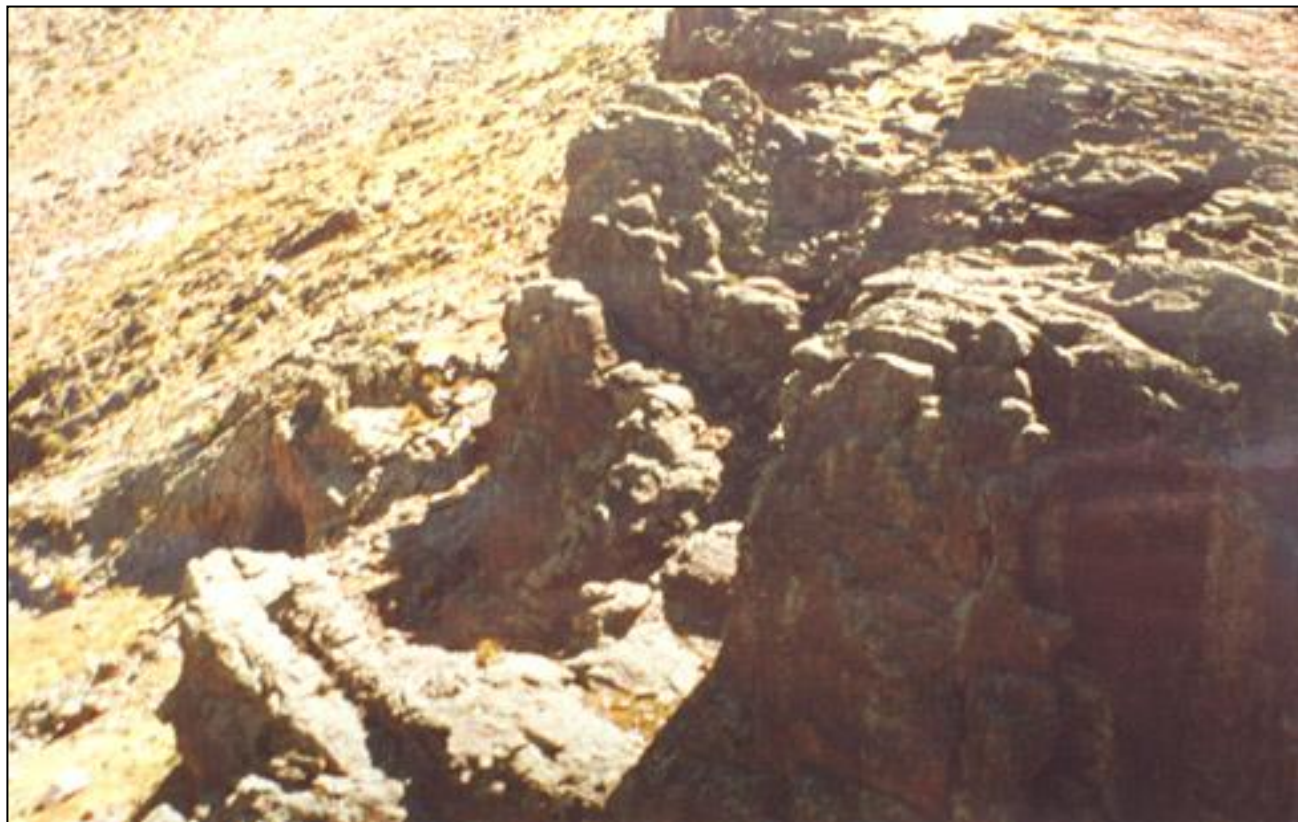
Foto N° 7.- Estribo Derecho. Presa Sihuis - Vista hacia aguas bajo.
