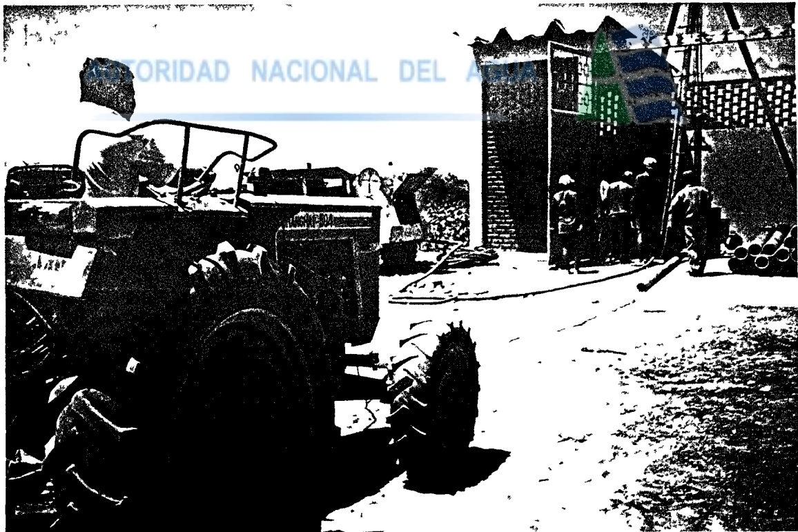
Fig. 02 Utilizando winche para la instalación de tubería de limpieza
