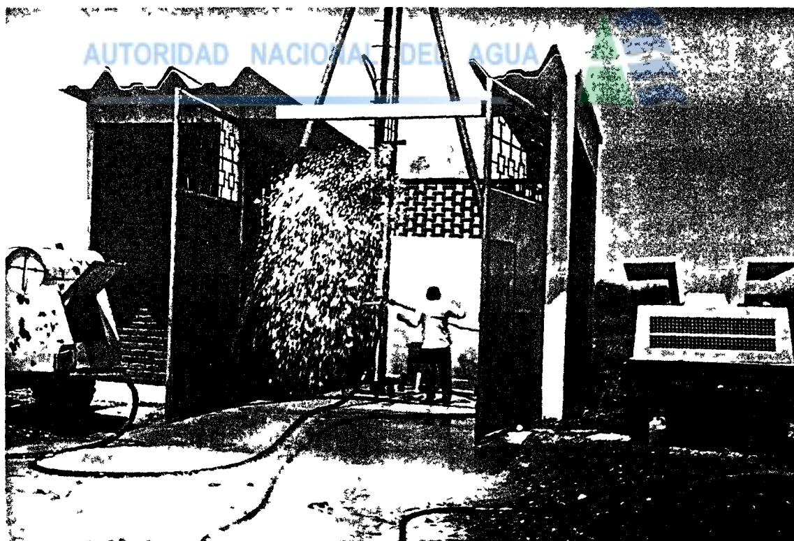
Fig. 04 Bombeo con aire comprimido
