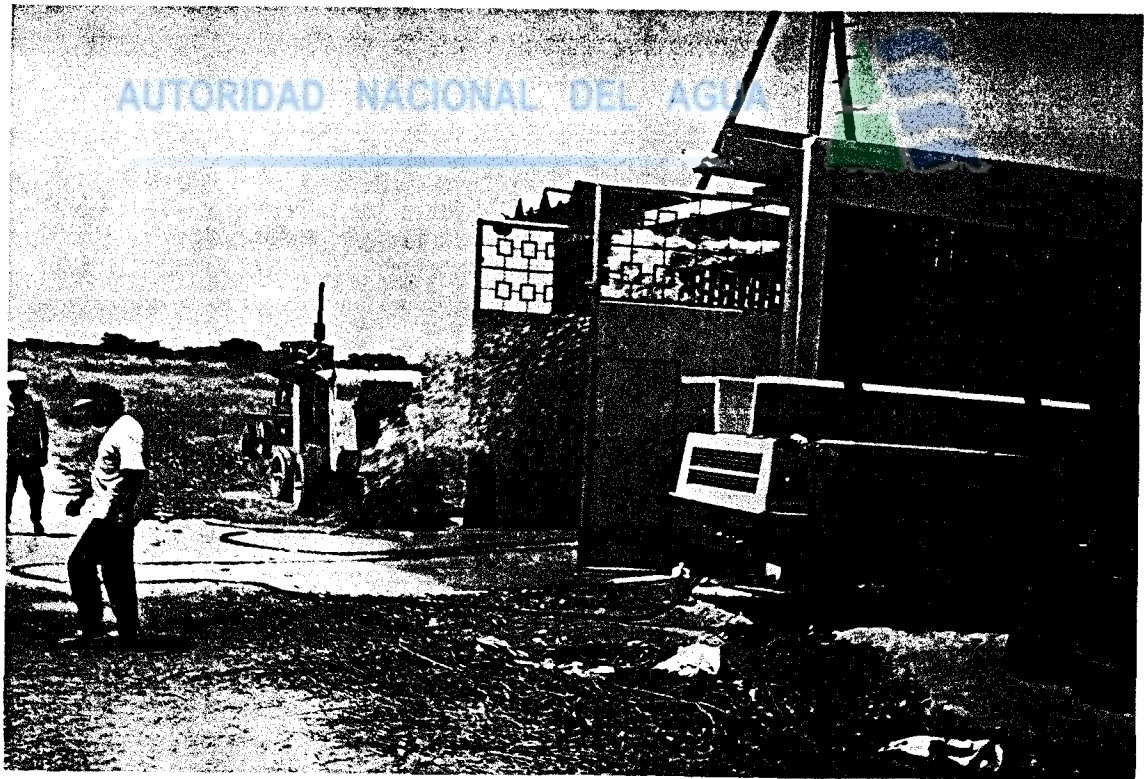
Fig. 04 Limpieza y desarrollo del pozo con aire comprimido
