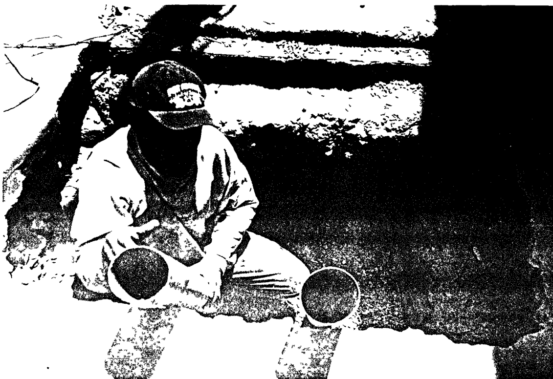
Fig. 01 Colocando Tubería de PUC para rellenar de grava
