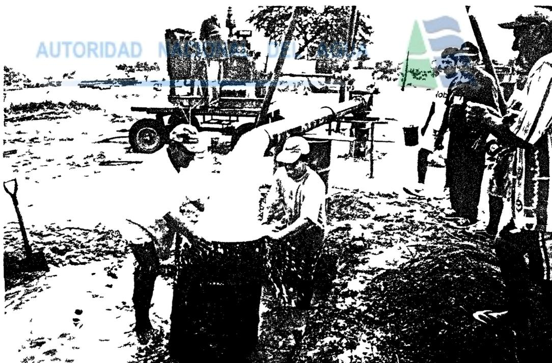
Fig 04 Prueba de bombeo aforo del caudal
