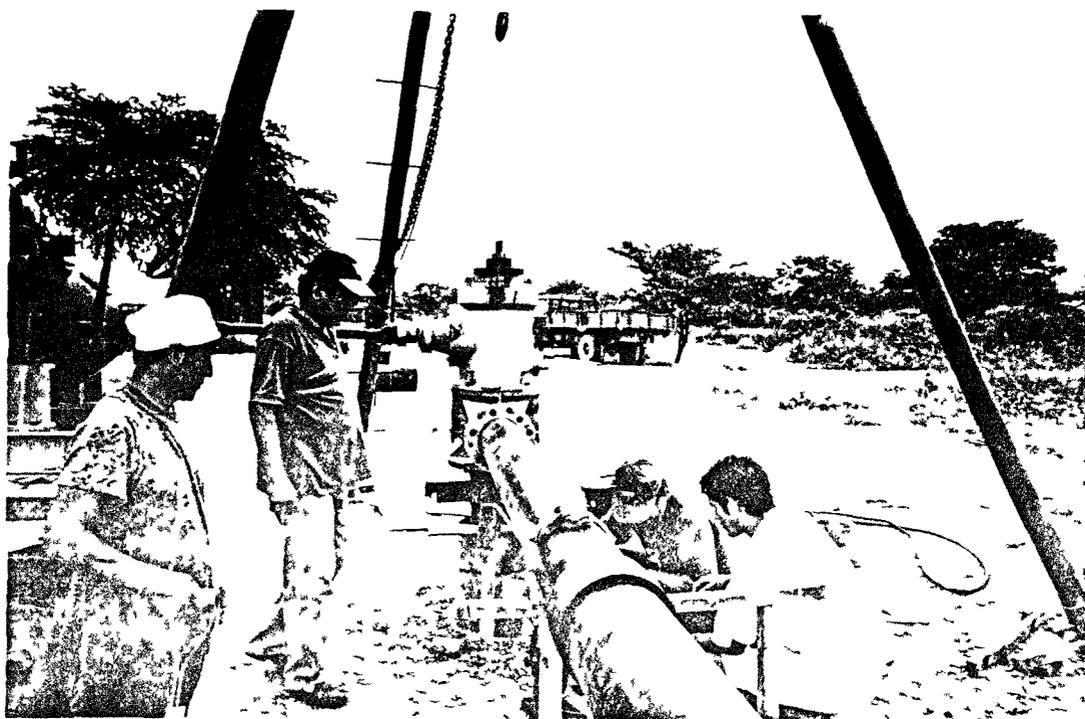
Fig 03 Prueba de bombeo medición del nivel dinámico
