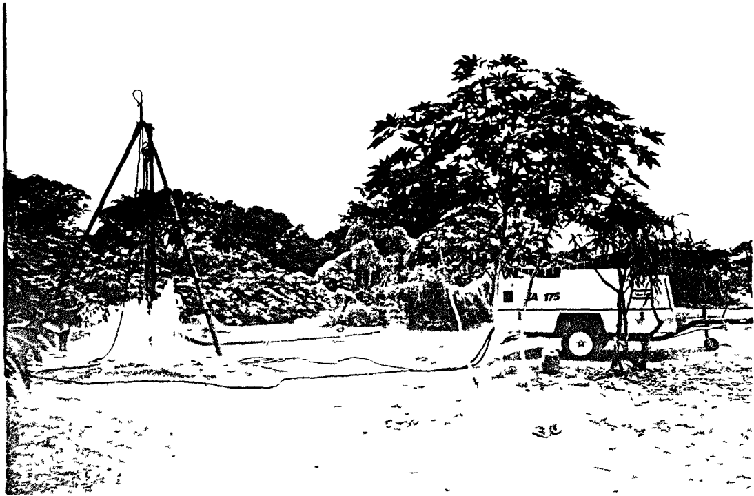
Fig 01 Agitación y Desarrollo de filtros con aditivos químicos mediante aire comprimido
