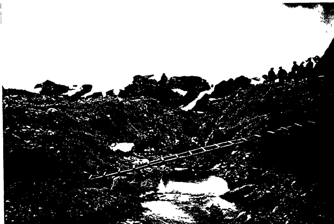
VISTA N° 04 : Zona de excavación del canal de desagüe, ubicado aguas abajo del dique provisional . Este canal permitirá evacuar las aguas de la laguna hacia la Qda. Honda.
