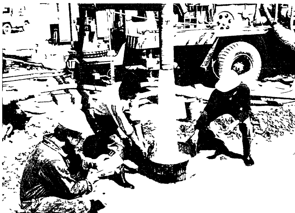
Aforo del pozo con aire comprimido durante el desarrollo
