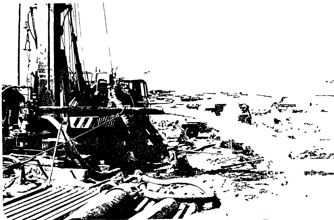
Alimpeza y desarrollo del pozo con aire comprimido
