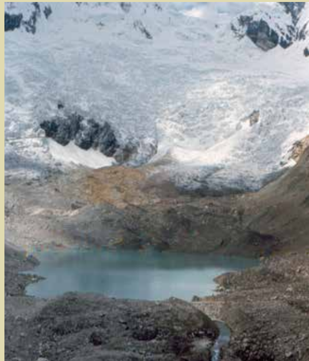
Vista fotográfica de la laguna Palcacocha (1974), donde vemos las dos infraestructuras descritas: el dique principal de seguridad y descarga, y el dique auxiliar en el extremo derecho (aguas abajo). También se observa la zona posterior de contacto entre la superficie del agua y el frente glaciar, que en la parte terminal se encuentra cubierto con una capa de detritos
