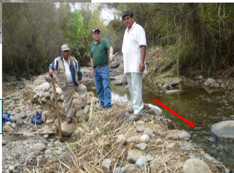
Toma de agua Cushipampa alta (Toma rustica)
