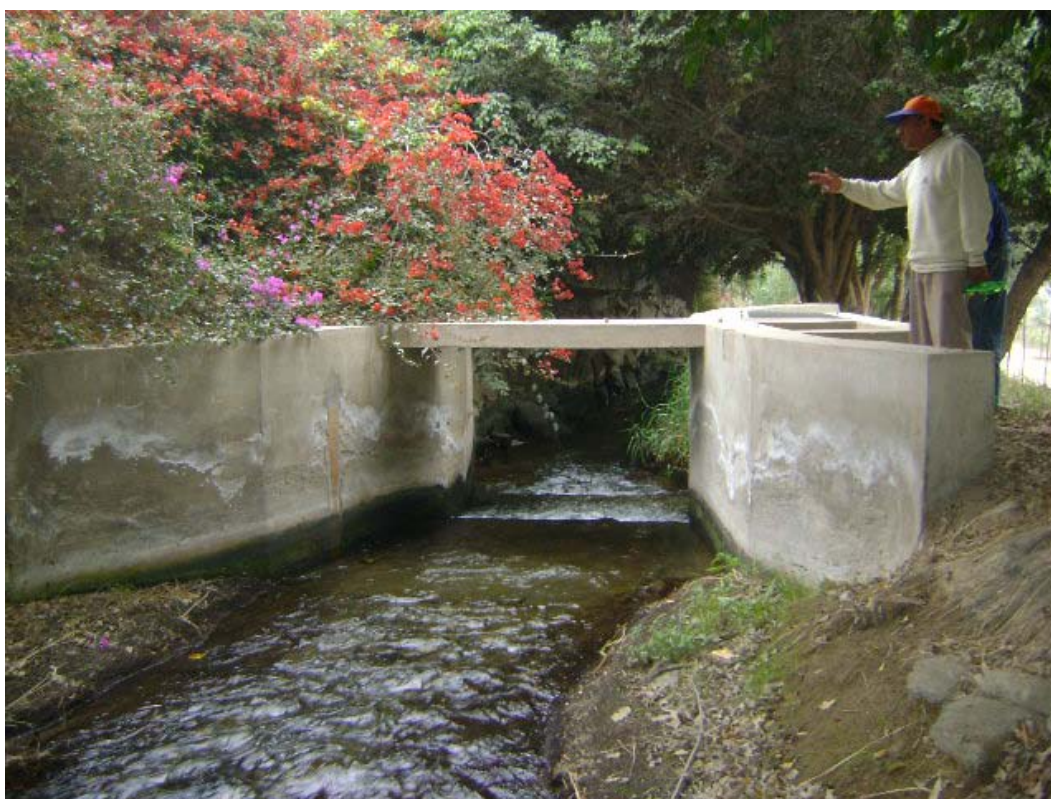
Medidor Parshall en CD Cieneguilla
