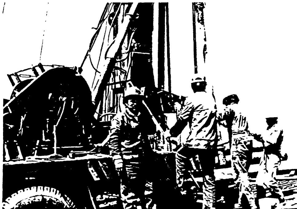
FASE PREVIA AL ENTUBAMIENTO DEFINITIVO DEL POZO
