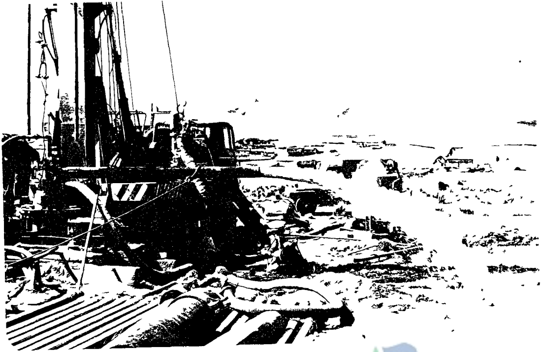
AUTOLIMPIA Limpieza y desarrollo del pozo con aire comprimido
