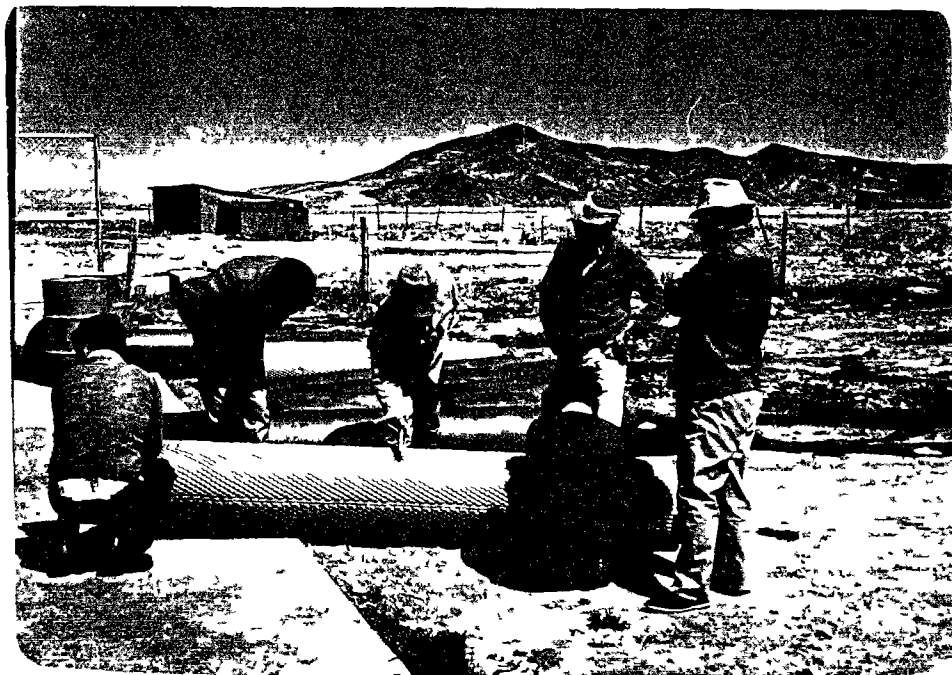
Inspección de filtros
