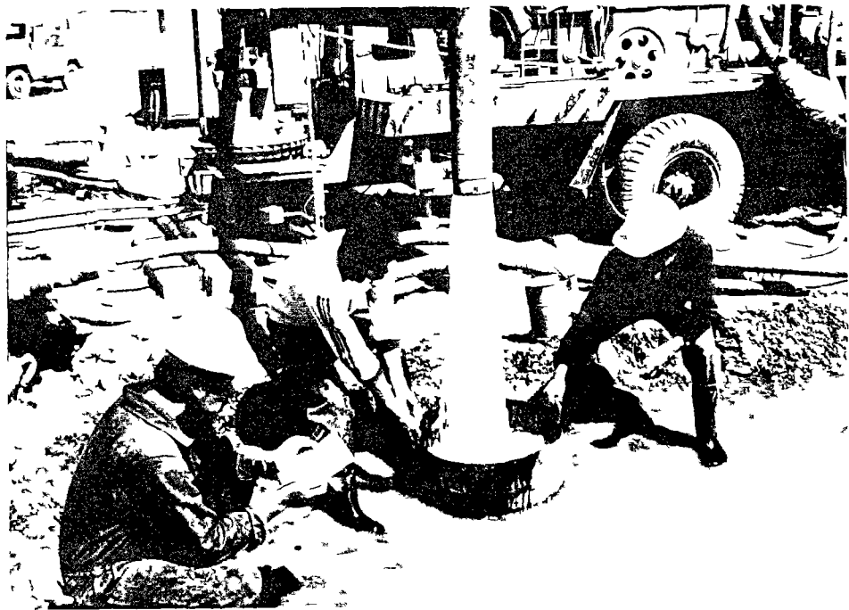
Aforo del pozo con aire comprimido durante el desarrollo
