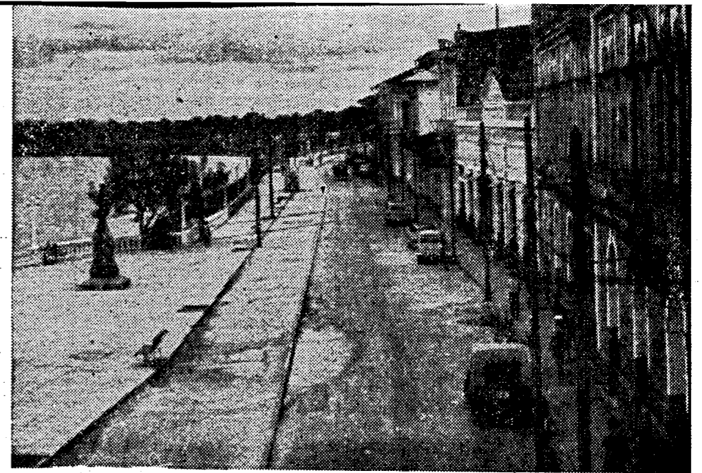
El Malecón Ha Sufrido Serios Daños.
