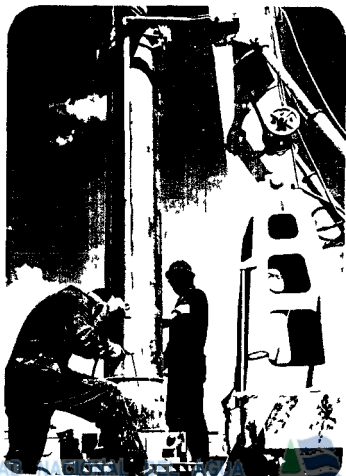
Instalación de tubería definitiva
